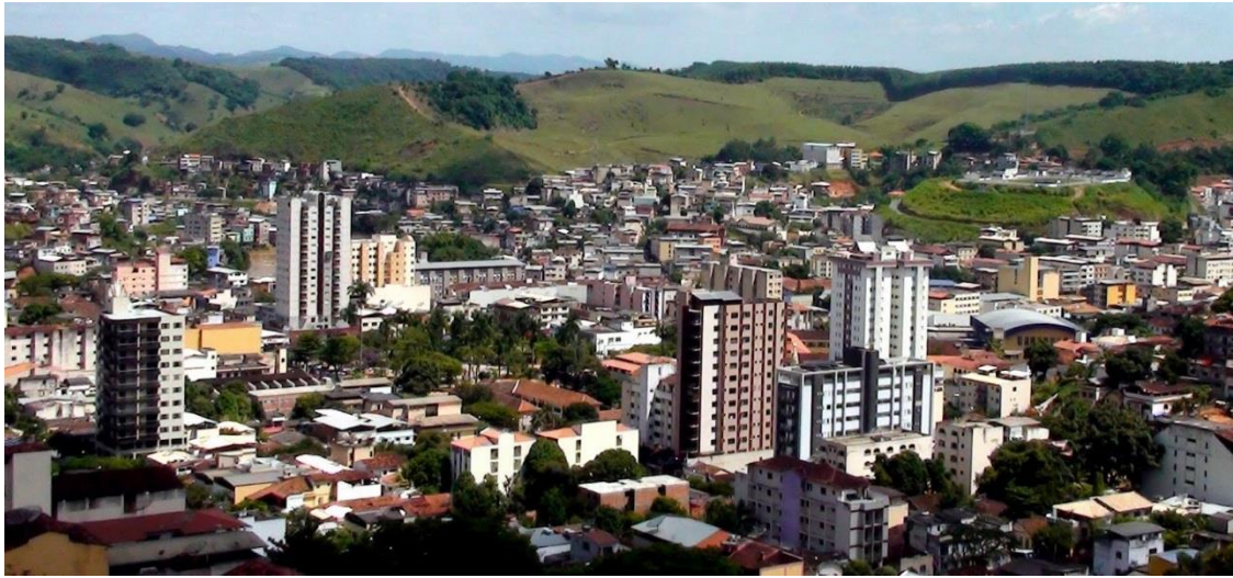
Foto 14: Ponte Nova – MG.
