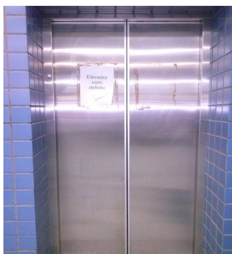
Figura 5: Elevador da Biblioteca Central da Universidade Federal de Viçosa, com um aviso dizendo que está quebrado.
